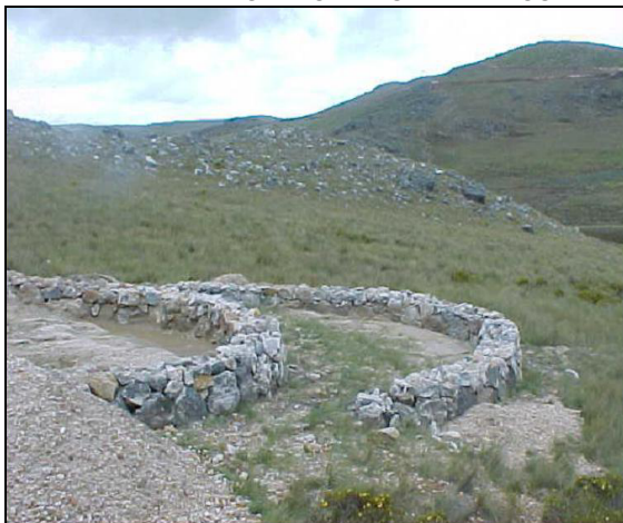
FOTO 6.6 BARRERA PARA CONTROL DE SEDIMENTOS
