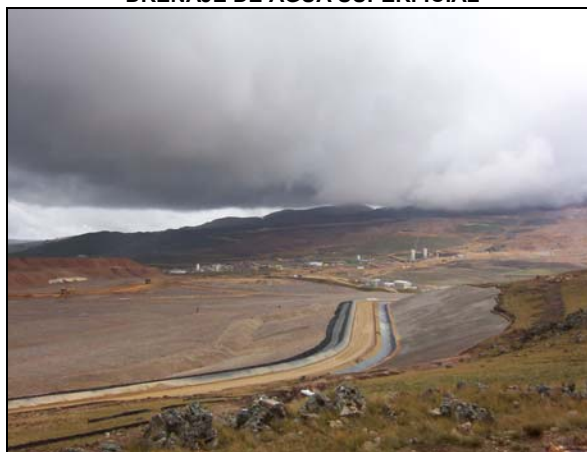
FOTO 6.5 DRENAJE DE AGUA SUPERFICIAL
