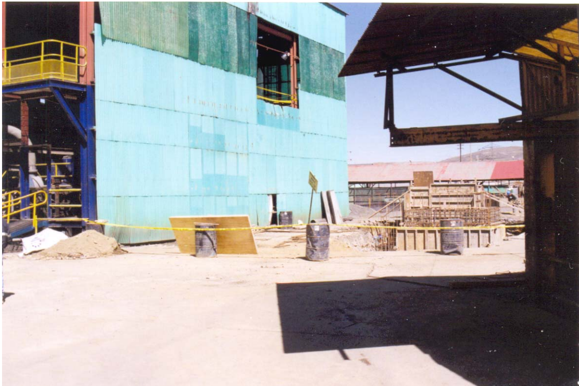
Fotografía N° 04: Área de la concentradora dentro de la planta industrial, con trabajos previos de construcción donde instalarán los nuevos equipos, la cinta amarilla delimita el perímetro. El tamaño de los cilindros permite obtener una aproximación de las dimensiones del área a ampliar.
