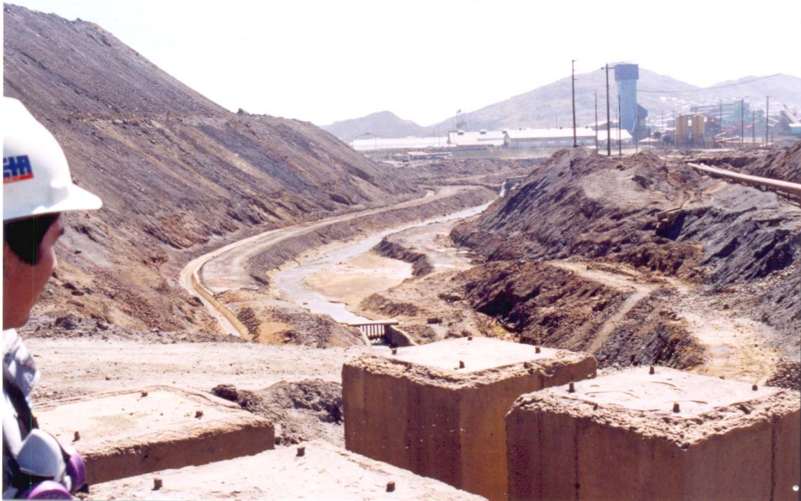
Fotografía N° 06: Canales de captación y conducción de drenajes ácidos al pie de un Stock pile que son conducidos a la planta de neutralización y el canal Paragsha que lleva los efluentes industriales y aguas servidas de la población de Paragsha.
