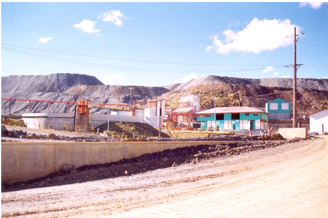
Fotografía N° 05: Vista Panorámica de la planta de neutralización de aguas ácidas a donde son bombeadas las aguas provenientes de los botaderos de desmonte Rumiallana.
