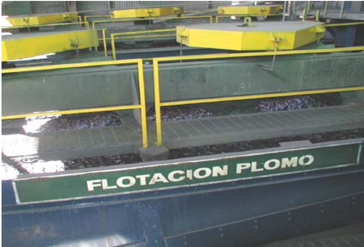
Fotografía N° 16: Sección Flotación de Plomo conformado por bancos, de celdas obteniéndose un concentrado de Plomo de 48-49 % Pb con una recuperación de 73 - 75% Pb y un contenido de 30 onzas/TM Ag.
