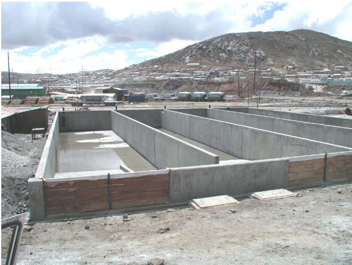
Fotografía N° 09: Poza de sedimentación en la zona industrial de la UEA-CP, tratara aguas del proceso de beneficio antes de su vertimiento.
