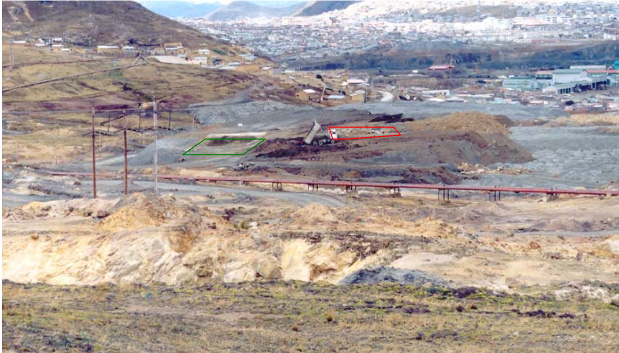
Fotografía N° 08: Stock Pile en Pampa Seca, que recibe el material de desmonte de construcción (en rojo). Véase además la poza de volatilización (en verde).
